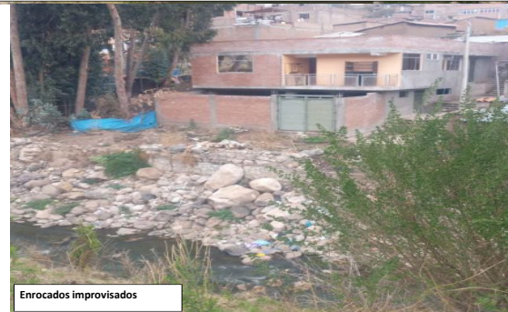
Imágenes como las aguas han ido erosionando lateralmente, y los pobladores han ido construyendo muros improvisados
